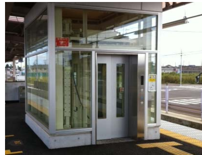
エレベーターの設置（ゆめみ野駅）
