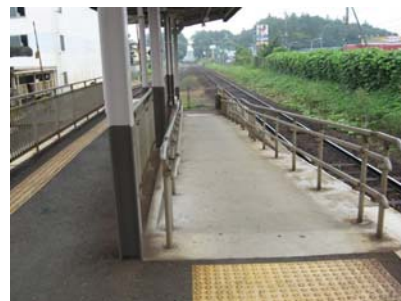
スロープの設置（新取手駅）
