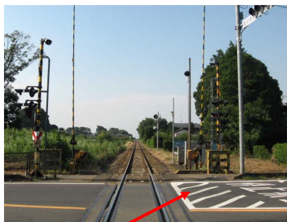
交通規制 停止禁止エリアの設置（梶内踏切） 警察・自治体と協力し事故防止に努めております
