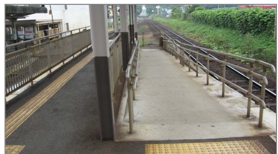
スロープの設置（新取手駅）
