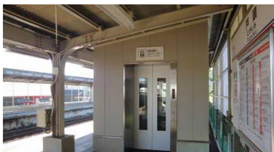
エレベーターの設置（戸頭駅）
