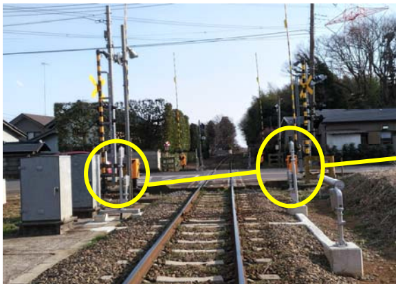
2016年度新設（梶内踏切道）
