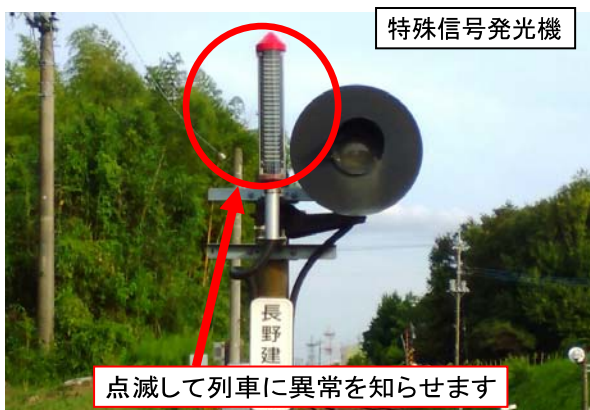
2016年度 新設（長野建設裏踏切道）
