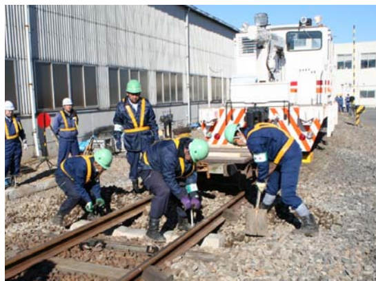
線路復旧訓練
