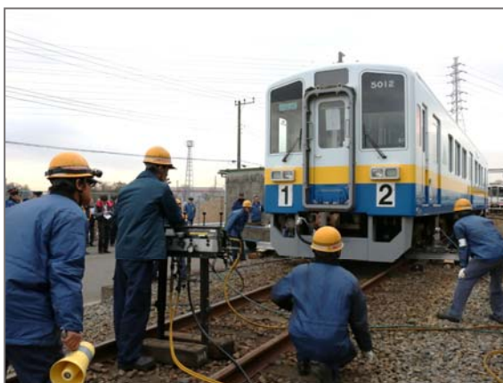
脱線車両の復旧訓練
