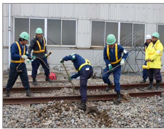
線路復旧訓練
