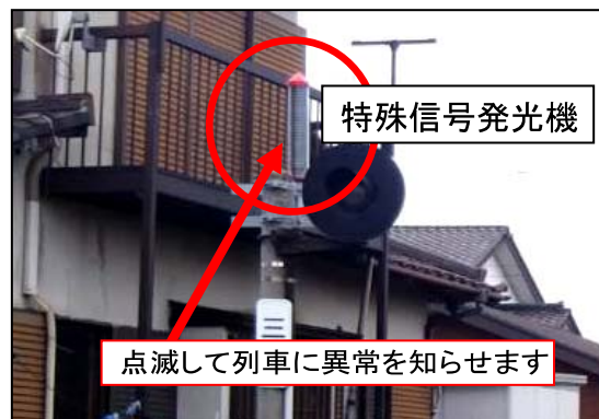
2018年度 新設（三妻踏切道）
