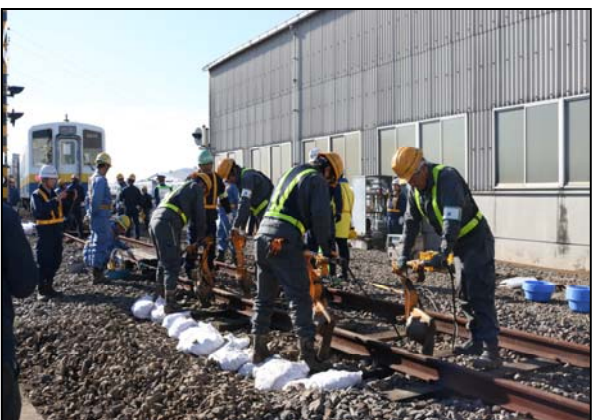
線路復旧訓練
