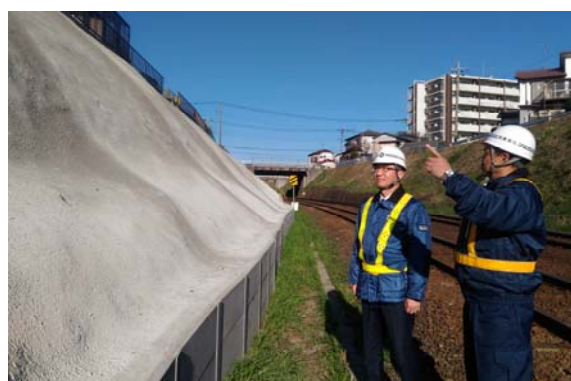
社長による工事進捗状況の確認（法面工事）
