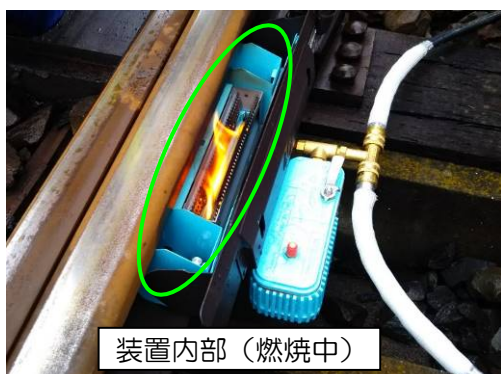
ポイントには融雪装置を8箇所設置
