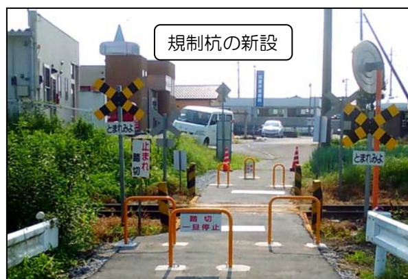
規制杭新設（乗用車通行禁止）宗道駅～下妻駅間
