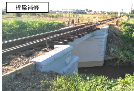
北水海道駅～中妻駅間（千代田堀川橋梁）
