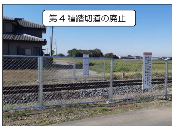
踏切道の廃止（柵を設置）玉村駅～宗道駅間
