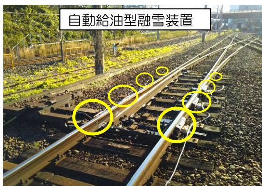
ポイントには融雪装置を8箇所設置
