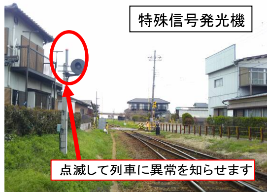
2019年度 新設（三妻踏切道）
