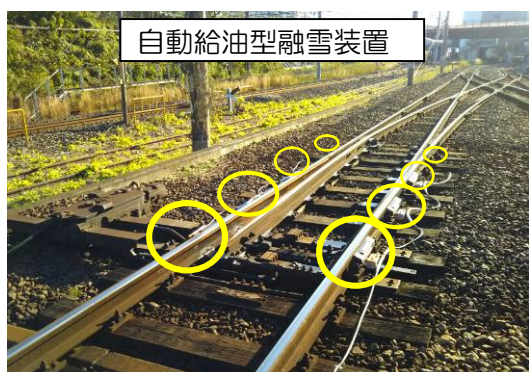
ポイントには融雪装置を8箇所設置
