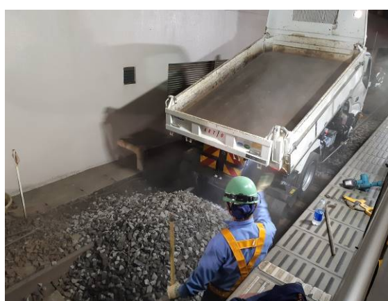
【取手駅構内の道床交換】
