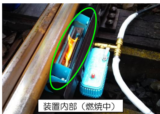
ポイントには融雪装置を8箇所設置
