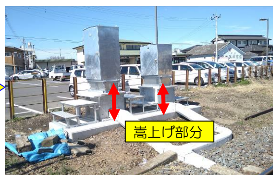
【農協倉庫前踏切（対策後）】
