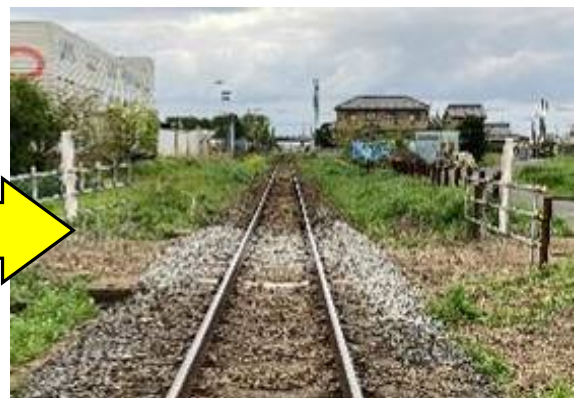
【廃止後】両側に侵入防止柵を設置しました
