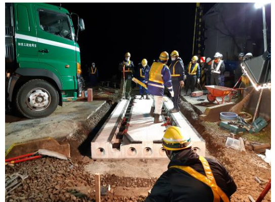
【夜間作業 踏切の改良工事】
