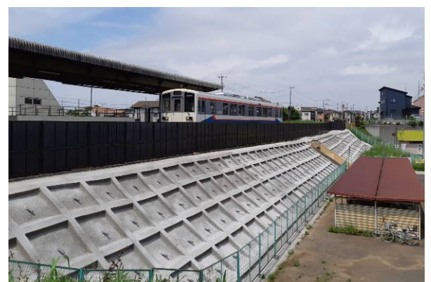
【南守谷駅構内の法面補強】
