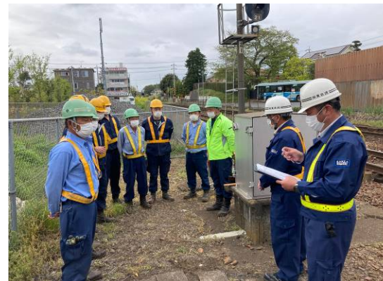
【請負業者に対する安全パトロール】
