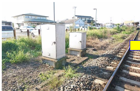
【農協倉庫前踏切（対策前）】
