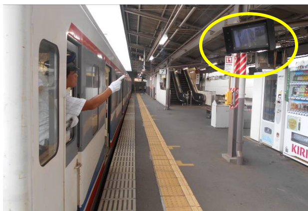
【運転士確認用モニター】
