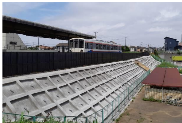
【南守谷駅構内の法面補強】
