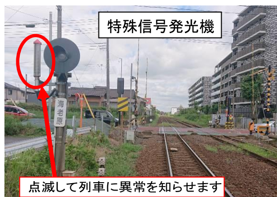
海老原踏切道
