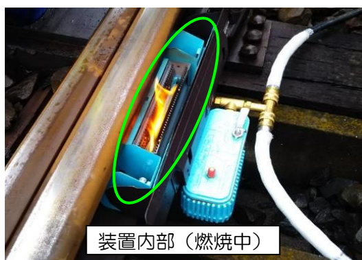
ポイントには融雪装置を8箇所設置
