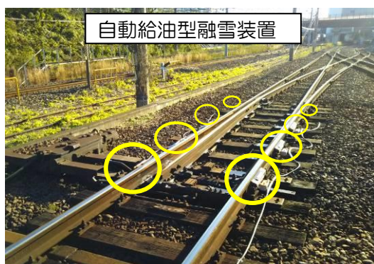
ポイントには融雪装置を8箇所設置
