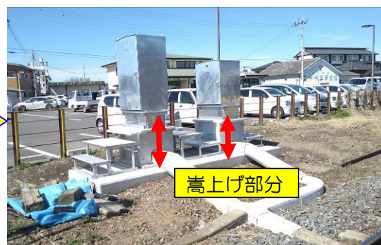
【農協倉庫前踏切（対策後）】
