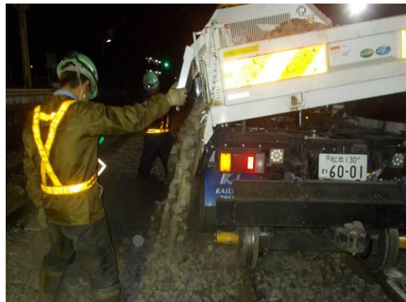
【小絹駅構内の道床交換】
