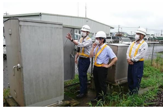
【安全統括管理者による職場巡視（踏切制御装置確認）】
