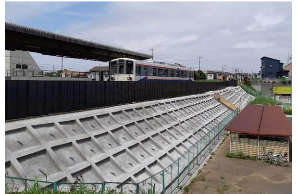
【南守谷駅構内の法面補強】
