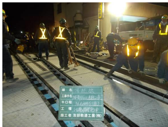
【夜間作業 踏切改良工事】
