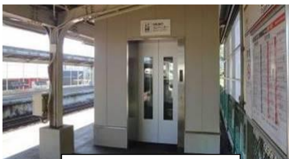
エレベーターの設置（戸頭駅）
