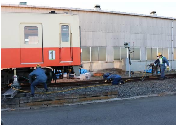
【脱線車両の載線作業】
