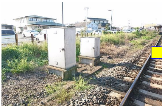
【農協倉庫前踏切（対策前）】
