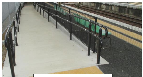
スロープ設置（小絹駅）
