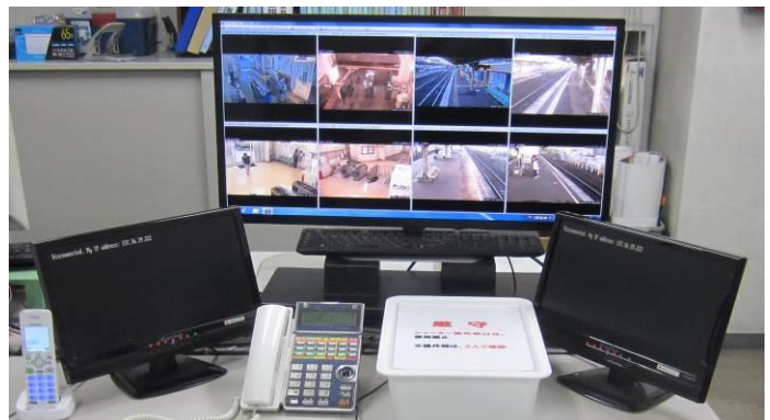
【監視モニター】
