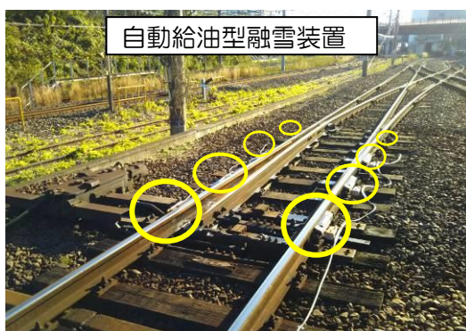
ポイントには融雪装置を8箇所設置
