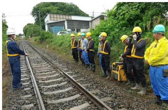
【請負業者に対する安全パトロール】
