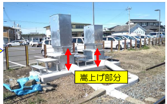
【農協倉庫前踏切（対策後）】
