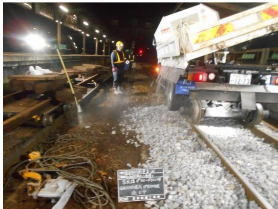
【水海道駅構内の道床交換】
