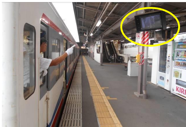
【運転士確認用モニター】
