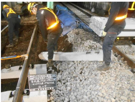
【水海道駅構内のPC枕木化】
