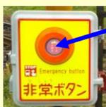
踏切内での脱輪・エンスト等の際は非常ボタンを戻らなくなるまで強く押して下さい。ただし異常時以外は使用しないで下さい。安全確認のため列車が止まり、運行に遅れが生じます。
