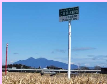
③上蛇排水樋管
