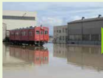
冠水した水海道車両基地
