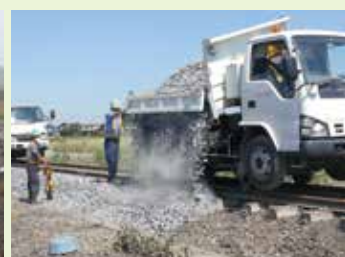
常総線の復旧作業の様子
